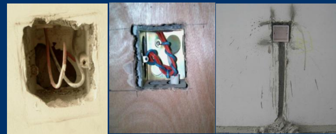
装修墙面暗装底盒
